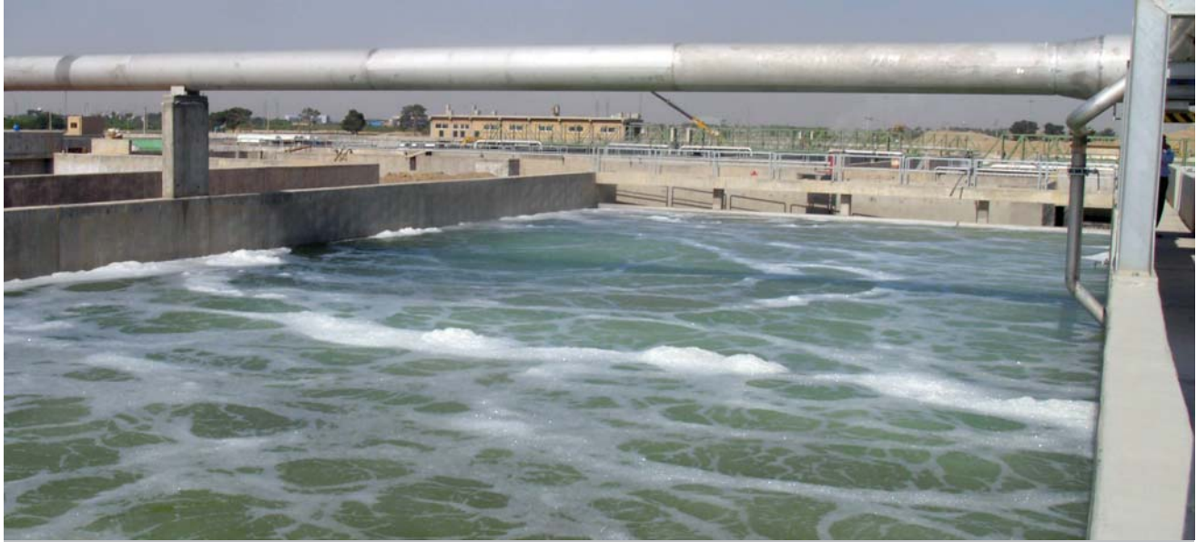
مراحل کارگذاری میان بِلت آب بند در دیواره های بتنی مخازن تصفیه خانه آب و فاضلاب
